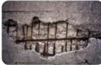
Spalling
