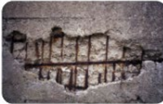
Spalling
